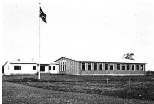
Vevelstad sentralskole. Oppført 1962.
