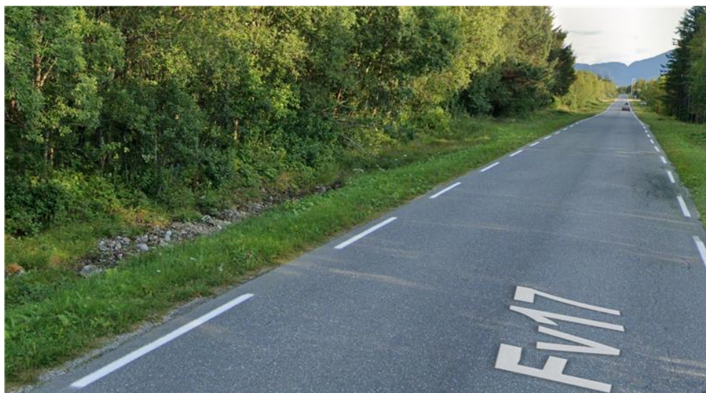
Figur 32. Eksisterende grøft langs Fv. 17
