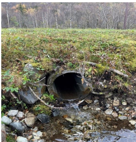
Figur 6 Bekkene som renner fra Liåvatnet mot Velfjorden, er alle lagt i stikkrenner som går under fylkesveien. Foto: Rambøll
