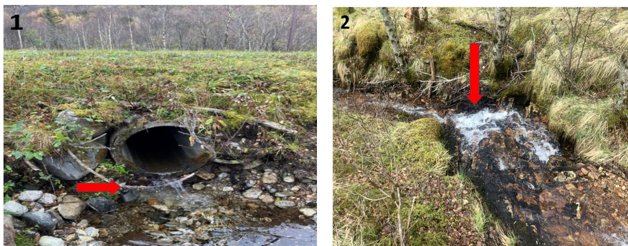
Figur 26 Til venstre vandringshinder i form av rør med høyt fall (bildet tatt 19.10.2021). Til høyre vandringshinder i form av bratt helling på fjell (bildet tatt 10.05.2022). Foto: Rambøll
