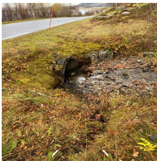
Figur 6 Bekkene som renner fra Liåvatnet mot Velfjorden, er alle lagt i stikkrenner som går under fylkesveien. Foto: Rambøll
