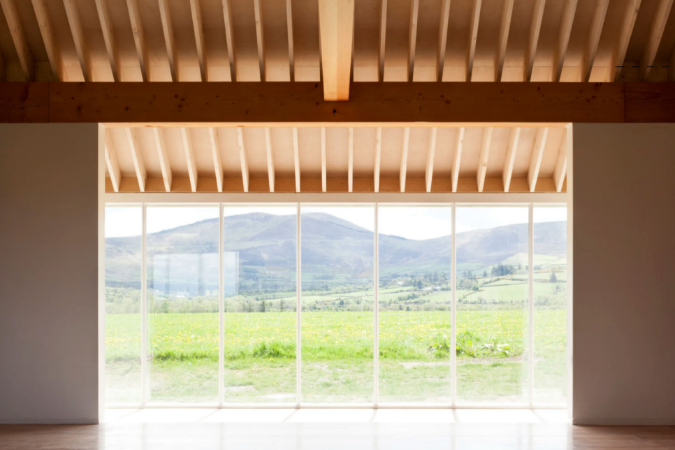
EKSEMPEL PÅ EKSPONERT KONSTRUKSJON I LIMTRE
