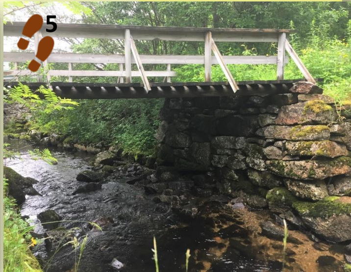
Korsvik-bruen, oppført i 1925. Frem til da hadde folk krysset elven ved hjelp av såkalte «hoppesteiner». Bruen som i dag brukes, ligger rett ved, og ble oppført på 1960-tallet.
