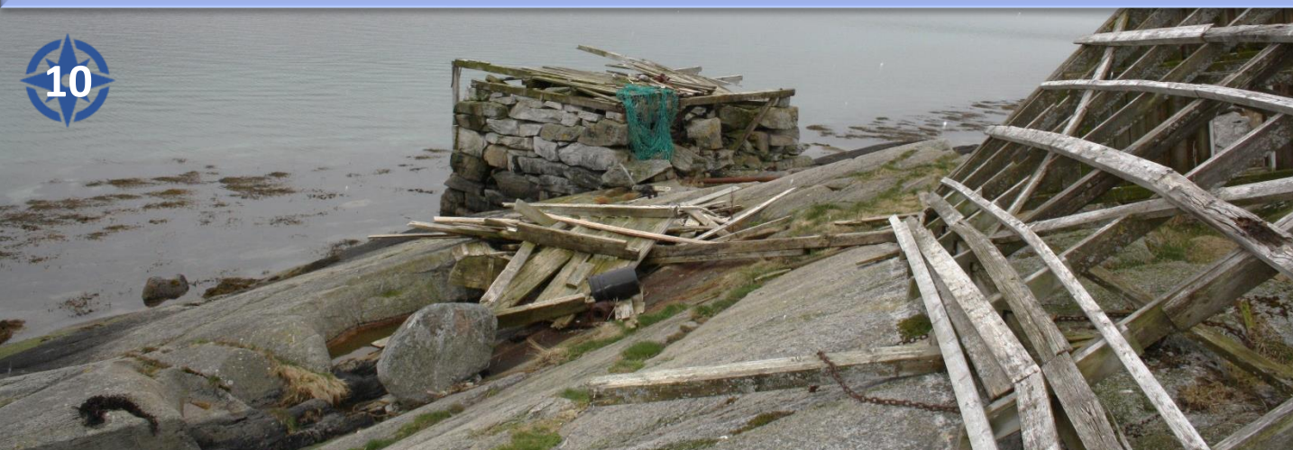
Mur etter brygge, Lendingen, Hamnøya. Trevirket som vises på bildet er rester etter taket. Antatt oppført på begynnelsen av 1900-tallet. Foto Torhild Haugann
