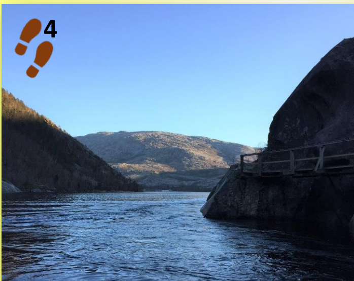
Gangbru ved Storstraumen i Visten. Gangbruen ble laget tidlig på 1900-tallet. Gjennom årenes løp er det utført forbedringer flere ganger. Gangsti til Aursletta ble ferdigstilt i 2013.
