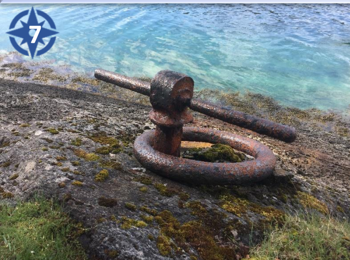
T-bolt med ring, den midterste av tre bolter på strekningen Hamn til Blesen. Foto Torhild Haugann
